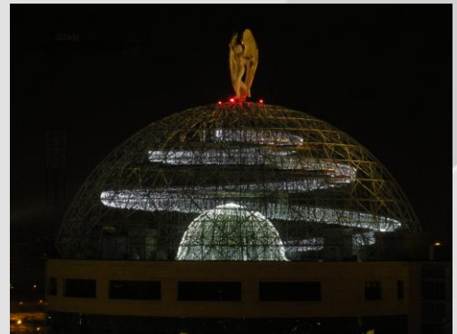
IMPIANTO DI ILLUMINAZIONE (ITALIA)
