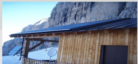
Impianto fotovoltaico isolato da 3,5 kWp - Dolomiti - 2600 m
